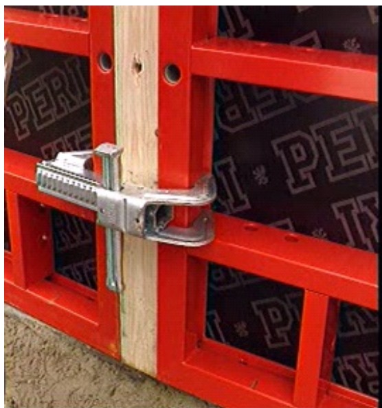
Рис. 13. Соединение щитов с помощью замков опалубки
