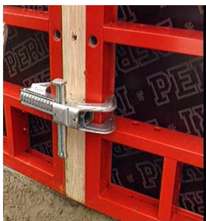
Рис. 14. Соединение щитов с помощью замков опалубки. 1 – крайний щит, 2 – прямолинейный щит, 3 – соединительный инвентарный замок.
